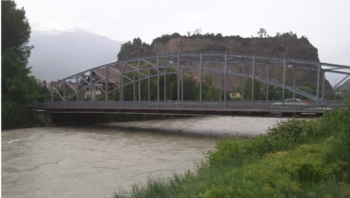
Stahl-Bogenbrücke von Chippis
